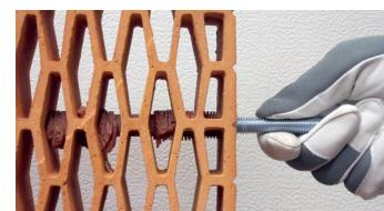
4. Вращательным движением установить металлическую шпильку в сетчатую гильзу на требуемую глубину.
